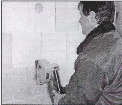
Schlitzen der Ziegel mit der Schlitzfräse.
